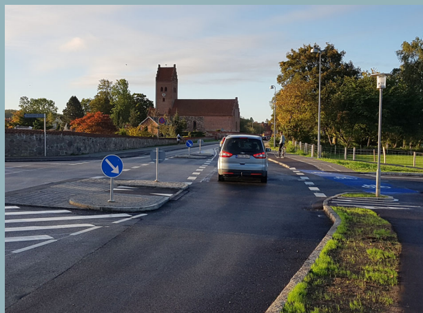
Forsætning af vejens forløb og nye krydsningsheller øger trafikikkerheden for bløde trafikanter på Frederiksborgvej.
