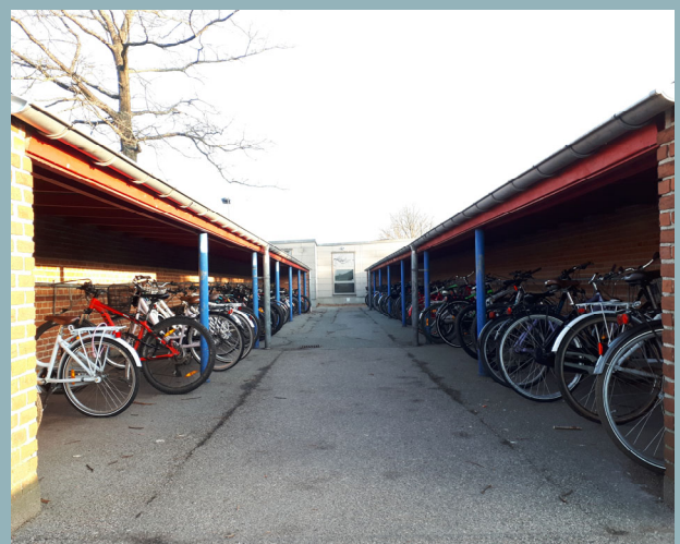
Overdækket cykelparkering ved Lynge Skole
